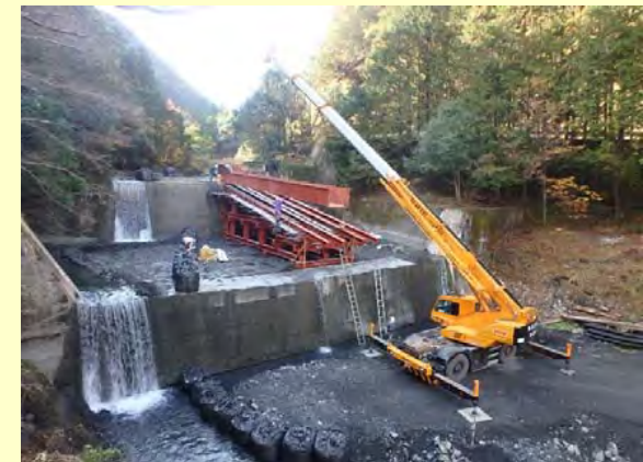
仮設工(仮水路鋼製樋設置状況)
