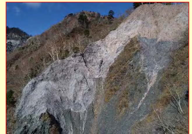
仮設撤去完了
