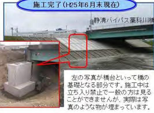
左の写真が橋台という橋の基礎となる部分です。施工中は立ち入り禁止で一般の方は見る事ができませんが、実際は写真のような物が埋まっています。
