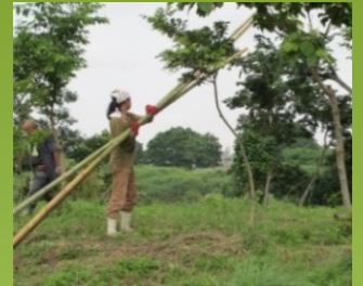
河道内樹木伐採作業
