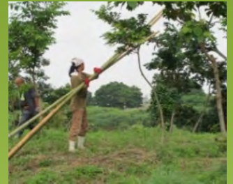
河道内樹木伐採作業
