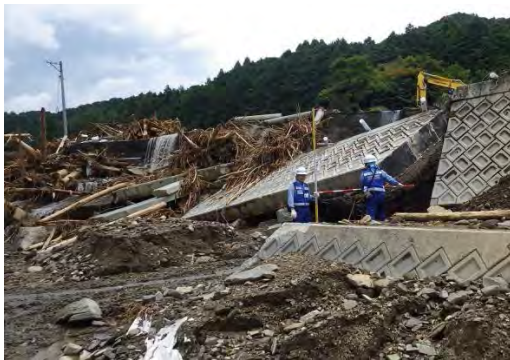
被災調査状況
