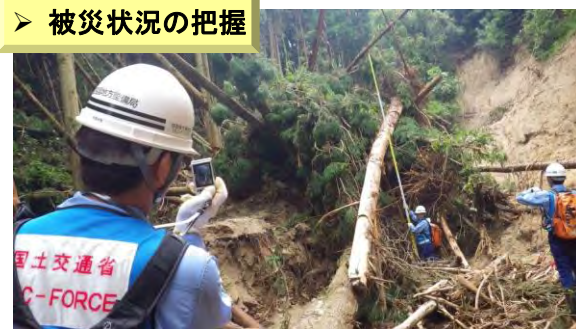
【H26.8 広島土砂災害】 (広島県広島市)
