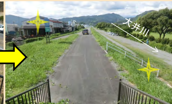
工事完成後の状況
