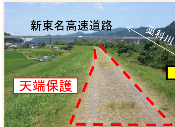
工事前の状況
