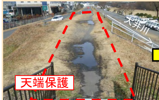
工事前の状況
