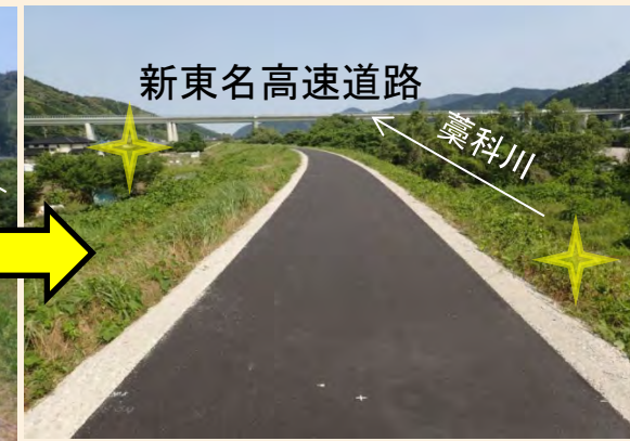
工事完成後の状況
