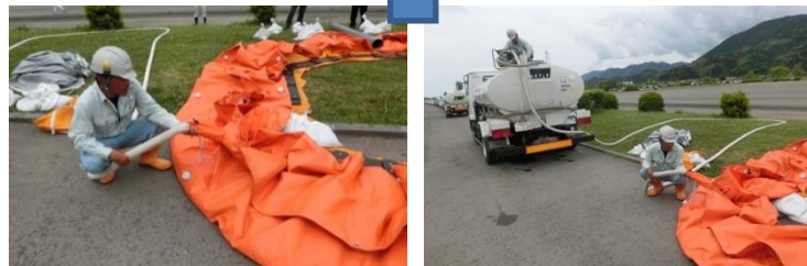
水のうに注水します。
