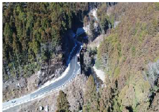
県道小松田口線の拡幅状況（平成30年1月撮影）
