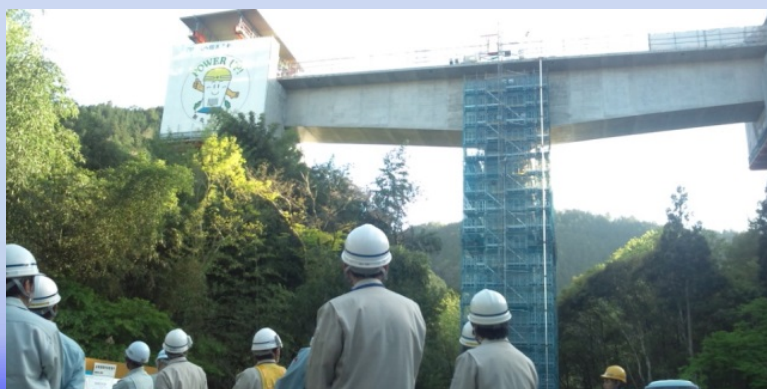
新丸山ダムの付替道路工事（新小和沢橋）の視察状況
