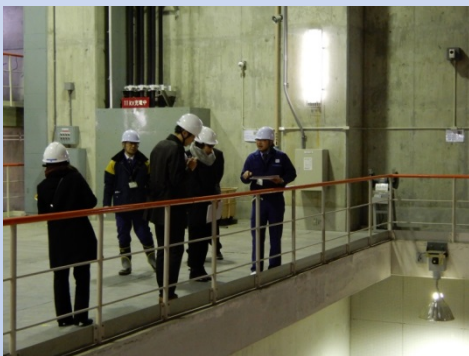
関西電力(株)新丸山発電所
