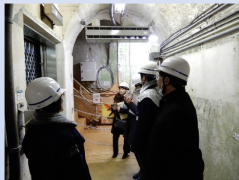
丸山ダム堤体内部
