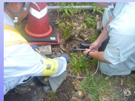
地下水位の計測
