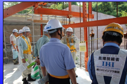
橋梁上部工工事説明
