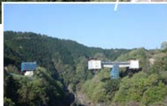
工事名：平成28年度 新丸山ダム并尻八百津複新小和沢橋PC上部工事 請負者：株D-Iインフラ建設 2径間連続ラーメンPC箱桁橋 橋長 L=240.0m
