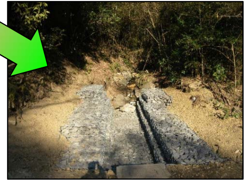
② 小和沢地区 排水処理作業
