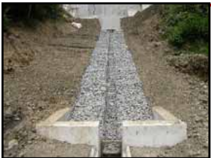
沢処理(原石山線を横断する沢の付替(本設水路))
