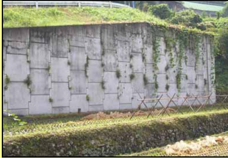
H11年度施工例
