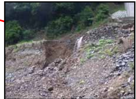
沢周辺の法面崩落 ※復旧は維持作業にて実施
