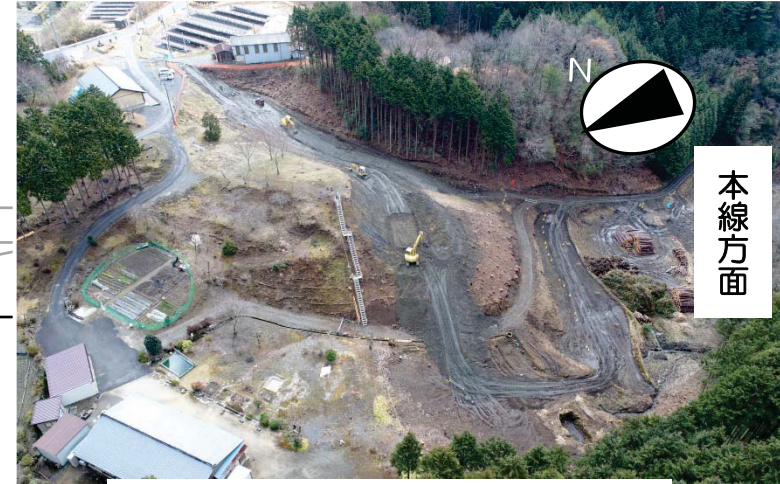
【付替国道418号 (恵那市側)】 工事用道路 施工中
