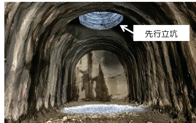
転流工【トンネル 平成31年1月貫通】
