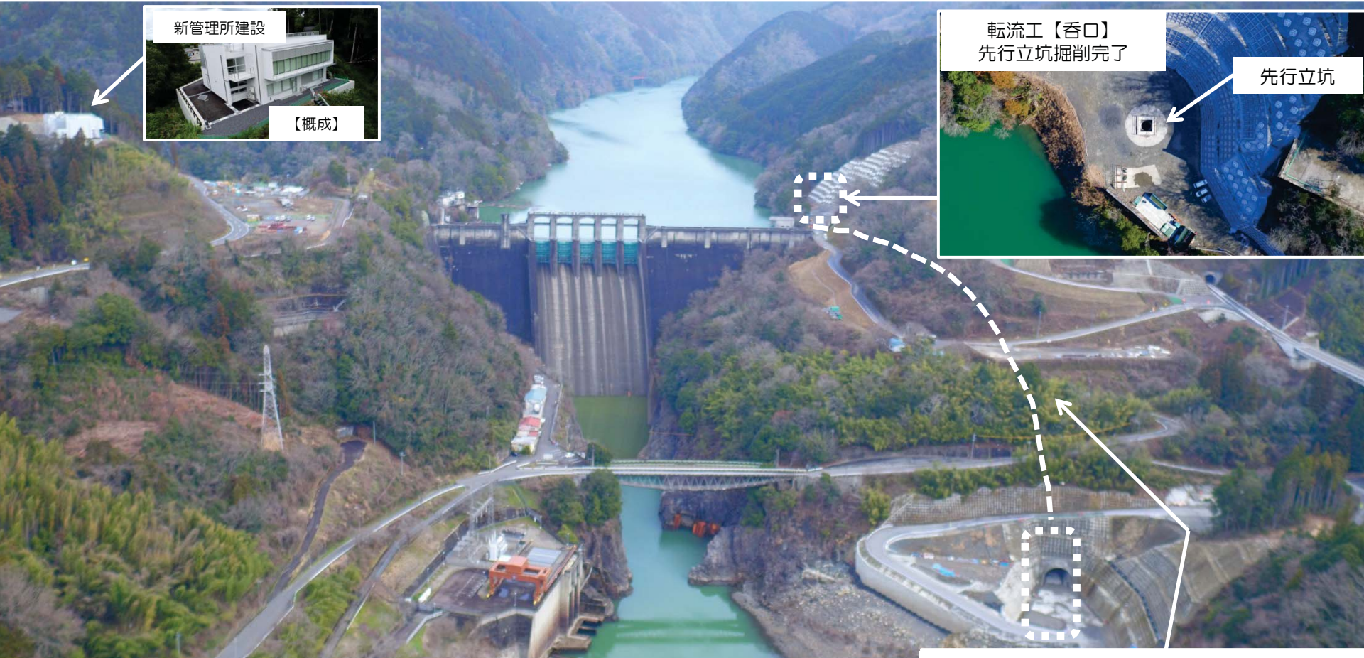
転流工【トンネル 平成31年1月貫通】
