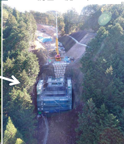
6号橋下部（A2橋台）橋台工施工中
