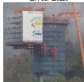
移動作業車組立状況
