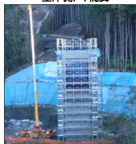
足場組立状況
