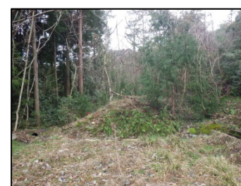
着工前（新小和沢橋A2橋台）
