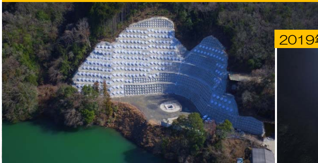
転流工事（呑口部）リーミング立坑掘削完了
