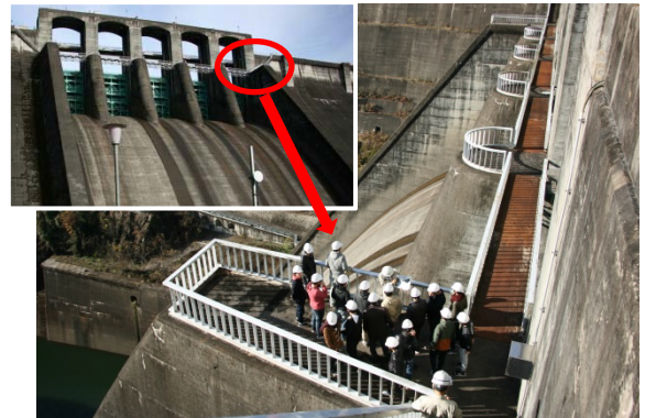
丸山ダムのゲートを間近で見ると大きさを実感
