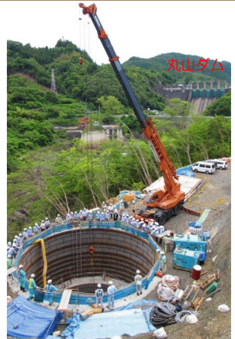
丸山ダム 橋梁の大口径深礎杭基礎掘削現場
