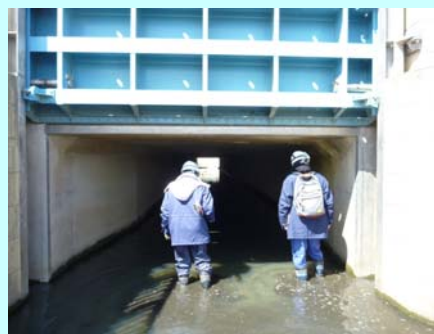
樋門内部状況調査
