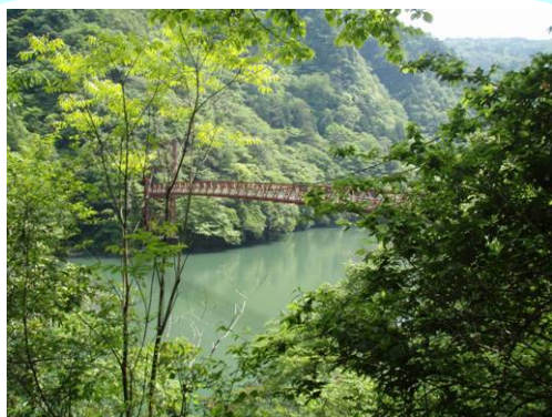
五月橋(右岸上流側から)
