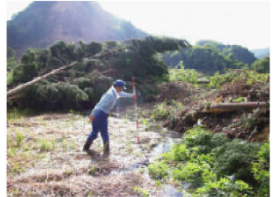
せき止められた支川の深さを調査中 (宮城県栗原市栗駒沼倉地内)
