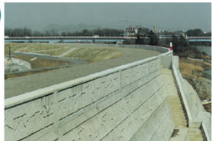
激特事業により完成した美濃加茂市右岸堤防
