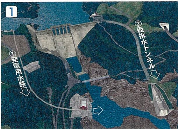
出水時に水を迂回させるための②仮排水トンネルを施工し、新ダムの形状に合わせて掘削します。
