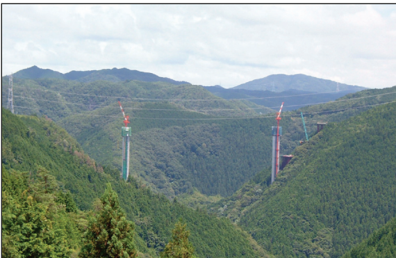
新旅足橋下部工完成 (H19. 2)
