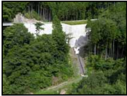
仮置土砂受入れ場 (補強土壁)
