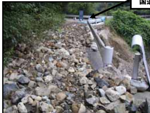
口杣沢土捨場 流末部 土砂流出状況
