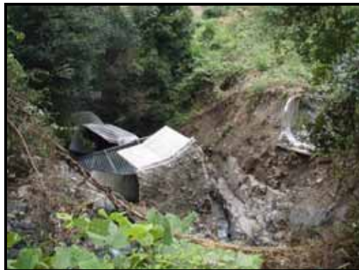
口杣沢地区土捨場 仮設水路被災状況
