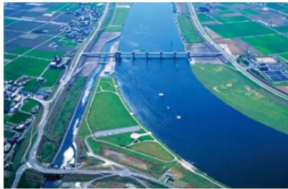
既得かんがい用水等の確保 (筑後大堰、水資源機構)
