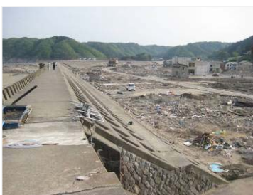
◇津波で損壊、越流した田老防潮堤 (岩手県宮古市)
