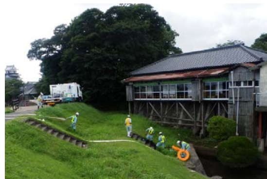
山国川支川中津川に配備された排水ポンプ車
