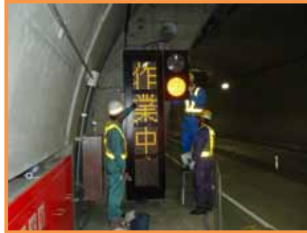
【トンネル非常用施設 （換気設備）点検状況】
