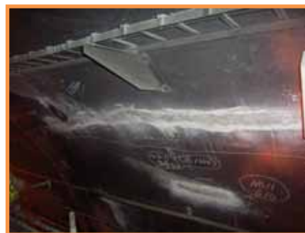
【補修後（炭素繊維補強）】
