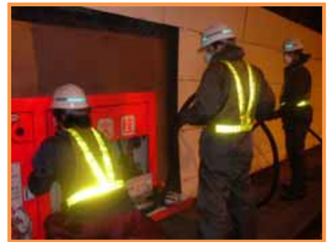
【トンネル非常用施設 （消火栓）点検状況】
