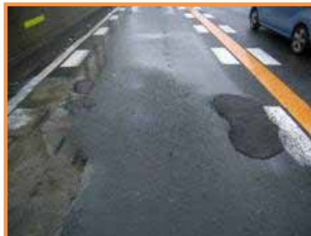
【補修後(穴埋め)】
