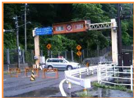
【異常時巡回（通行止め状況）】
