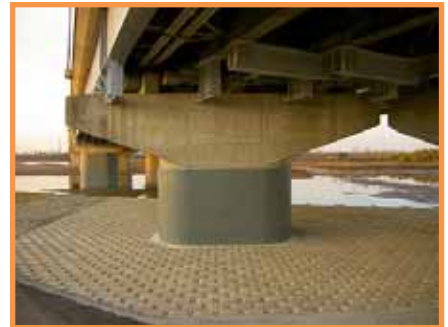
【対策後（鋼板巻き立て工）】
