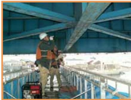
【吊り足場による点検】
