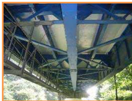
【補修状況（床版炭素繊維補修）】
