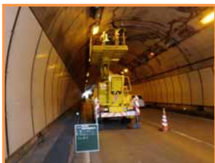
【高所作業車による点検】
