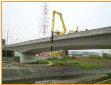
【橋梁点検車による点検】
