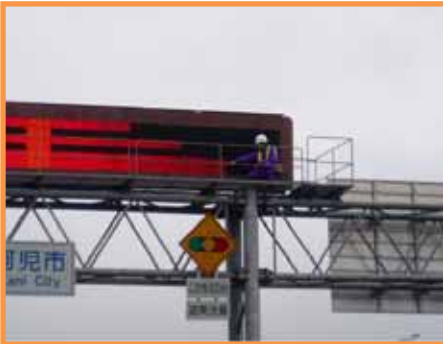
【道路情報板点検状況】
