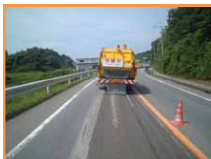
【補修後(凹凸削り取り)】
