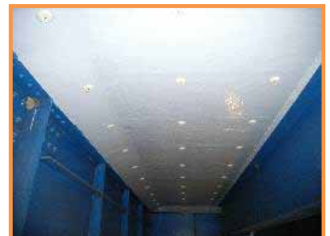
【補修後（床版炭素繊維補修）】
