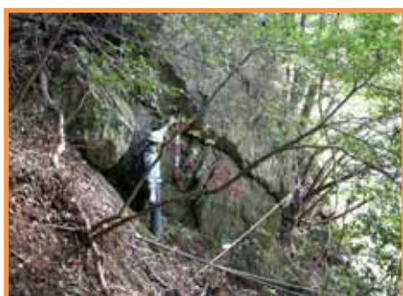
【法面転石の点検】
