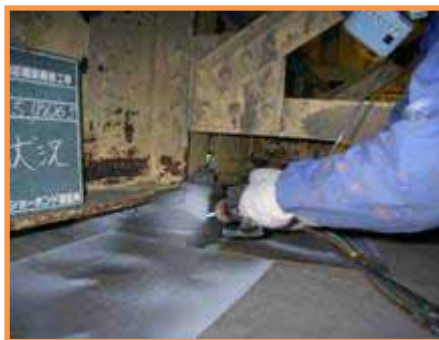
【補修状況（支承防錆処理）】
