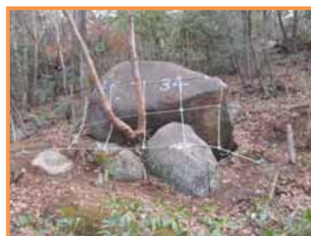
【対策後（ロープネット工）】
