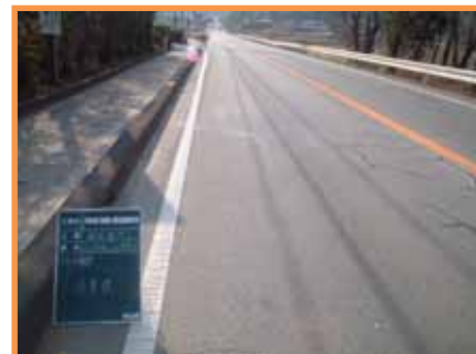
【補修後(注入完了)】
