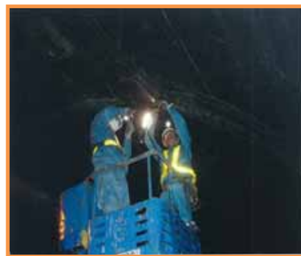
【トンネルランプ交換状況】
