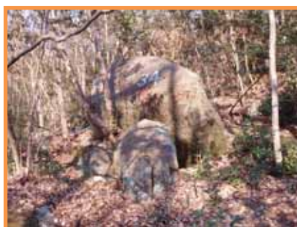
【対策前（ロープネット工）】
