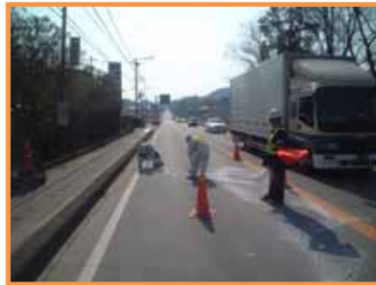
【補修作業状況(補修材注入)】
