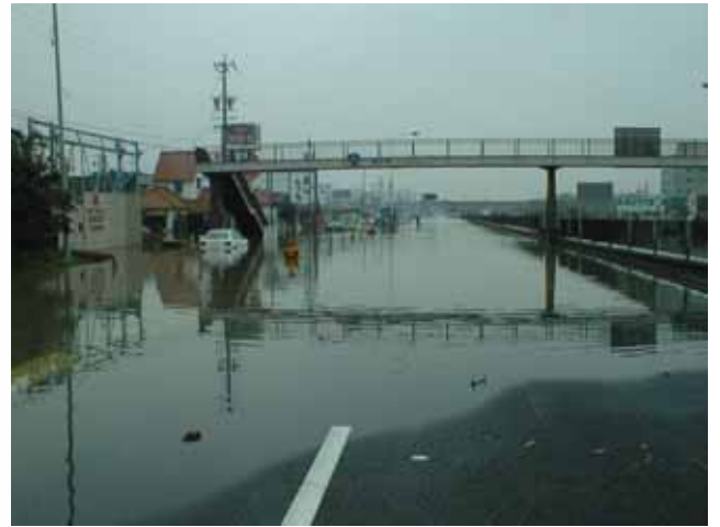
国道2号冠水状況
