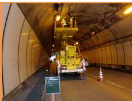
【トンネル点検】
