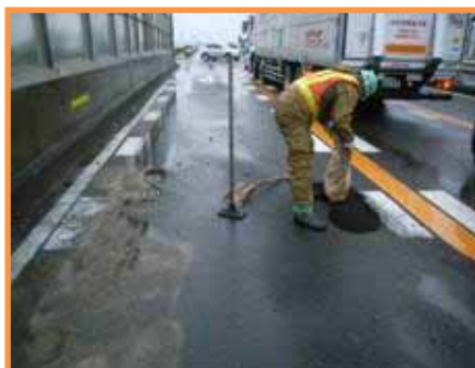
【補修作業状況】
