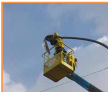
【ランプ交換状況】
