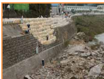
【応急復旧状況】
