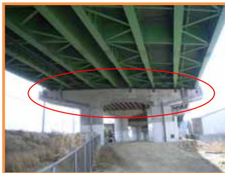
対策前（落橋防止装置）
