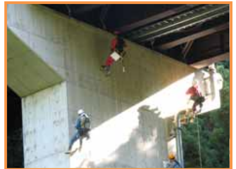
【ロッククライミング 工法による点検】
