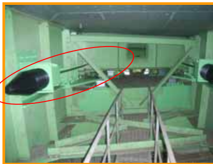
対策後（落橋防止装置）
