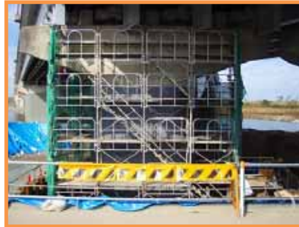
【対策中（下部工補強状況）】
