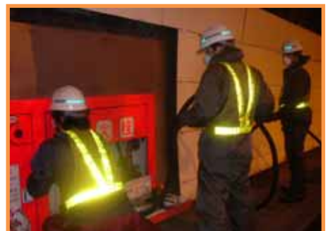
【道路設備点検】
