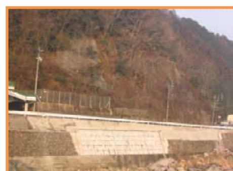
【補修対策作業後】
