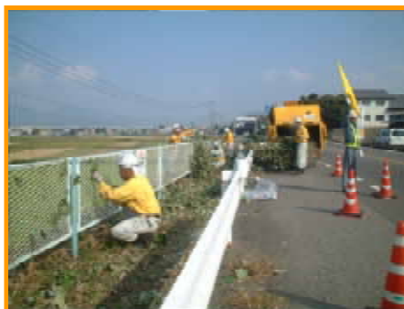
【除草作業状況】
