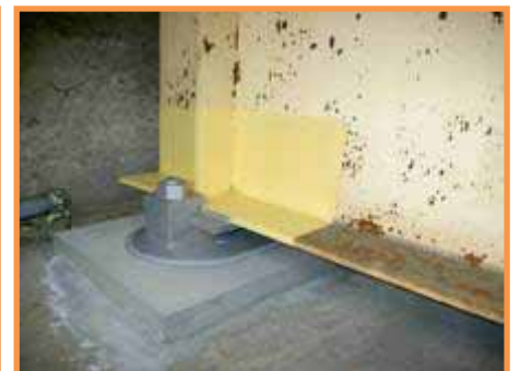
【補修後（重防食塗装）】
