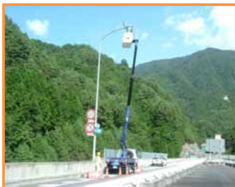
【ランプ交換状況】
