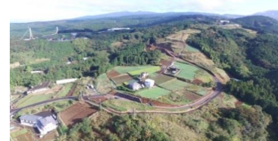
笹原工区 工事用道路 進捗状況
