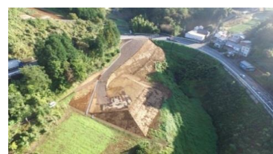
大曲工区 工事用道路 進捗状況
