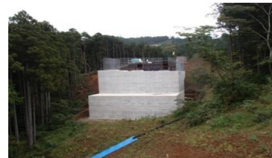
3号橋A1橋台
