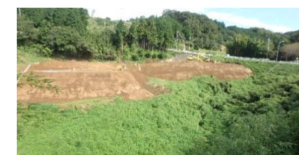
大曲工区着手前
