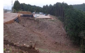
2号橋A2橋台
