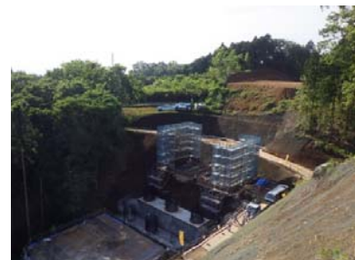
【4号橋 A1橋台】 【8号,9号L型擁壁】
