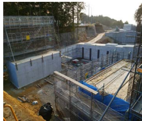
【5,6号現場打ちL型擁壁】
