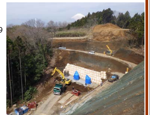
【4号橋A1橋台】
