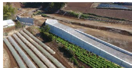
8-1,8-2号重力式擁壁
