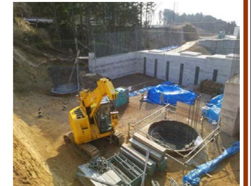
【5,6号現場打ちL型擁壁】
