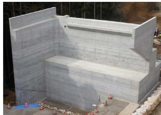
【4号橋A2橋台】
