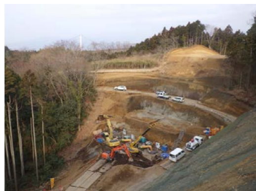
【4号橋A1橋台】
