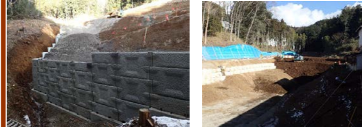
【本線工区】 17号補強土壁
