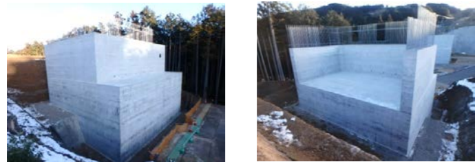
【2号橋A2橋台】完成
