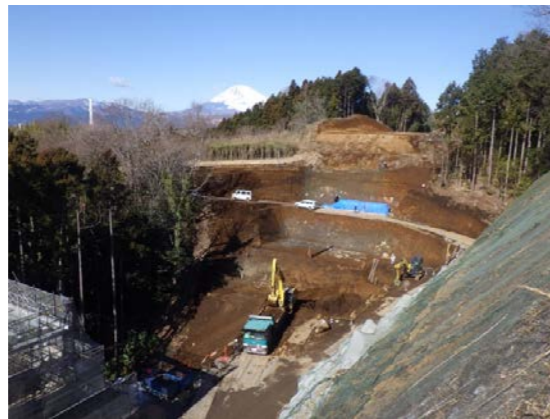
【4号橋A1橋台】
