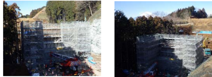
【4号橋A2橋台】
