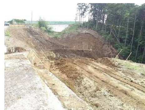
22号補強土壁箇所
