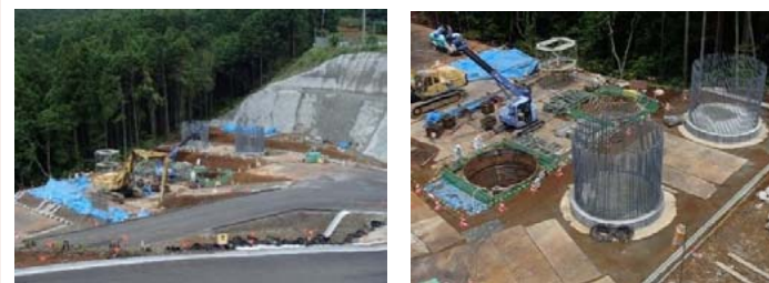
【エビノ木工区】2号橋A1橋台 深礎杭
