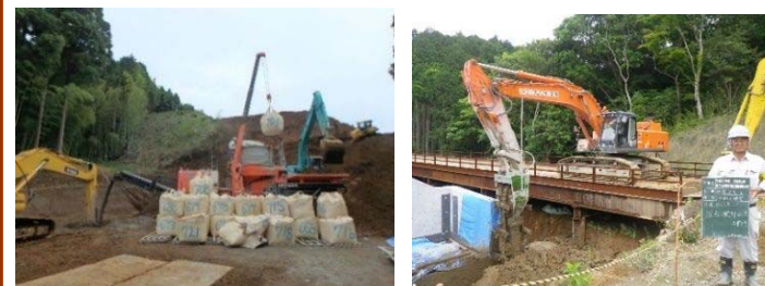
【セメント改良状況】
