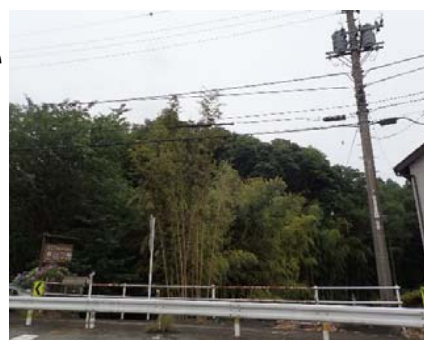
【大曲】埋土工事箇所
