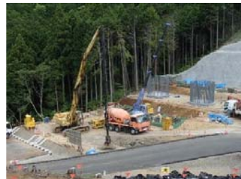
【前列杭施工状況】
