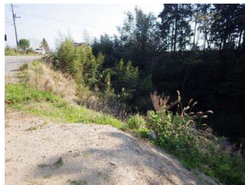
22号補強土壁箇所
