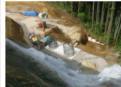
【4号橋A2橋台】
