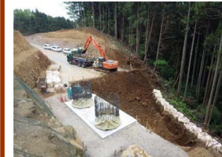
4号橋 A2橋台工 掘削・床掘り 作業状況
