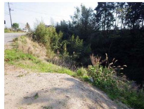
22号補強土壁箇所
