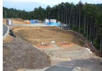
【エビノ木工区】 2号橋A2橋台 深礎杭
