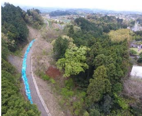
盛土施工箇所
