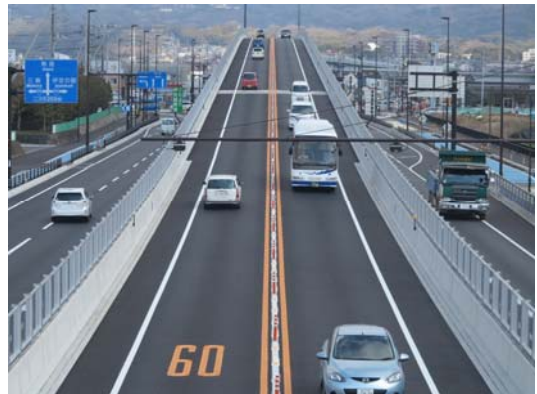
写真②函南塚本 IC 付近の状況 (大場・函南 IC 方面を望む)
