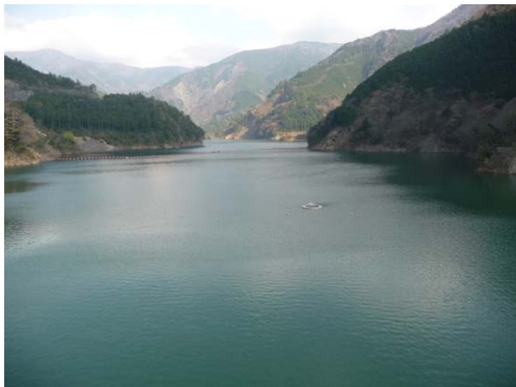
長島ダムより上流を望む(2009年4月6日)
