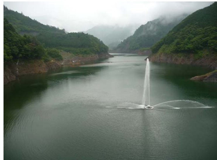
長島ダムより上流を望む(2009年6月16日)
