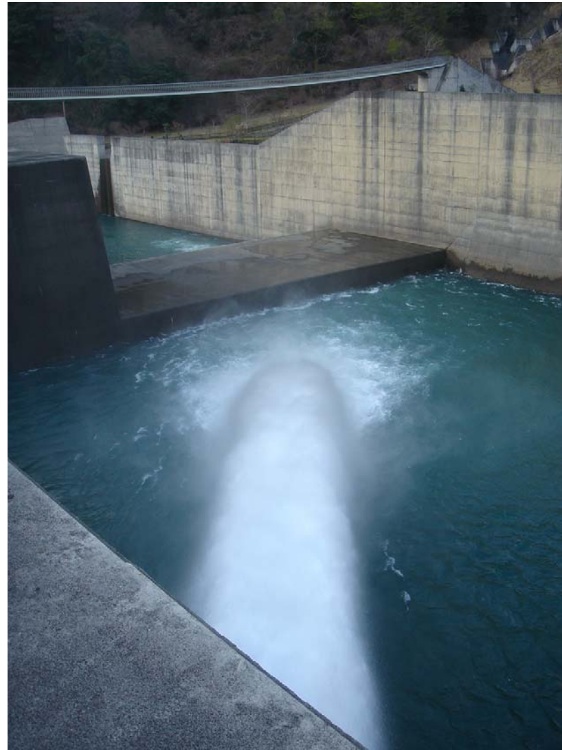
しぶき 長島ダム放流設備より飛沫橋を望む
