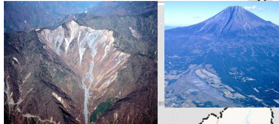
14 安倍川大谷山腹工
