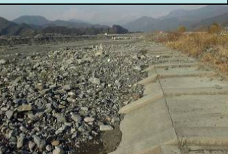
安倍川下流域の河床上昇状況
