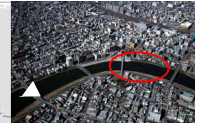
1 下河原地区河道掘削
