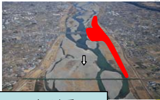
天竜川水系池田河道掘削
