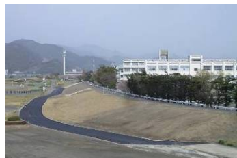
9 安倍川左岸堤防補強工
