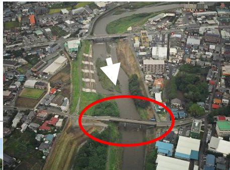
河積阻害となっている橋梁 狩野川水系黄瀬川橋
