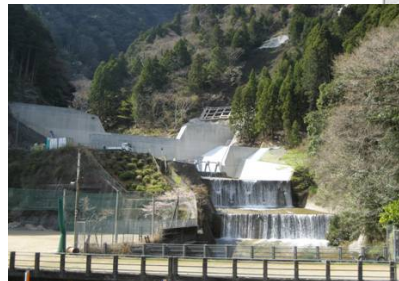
34 天竜川水系河内沢川砂防えん堤
