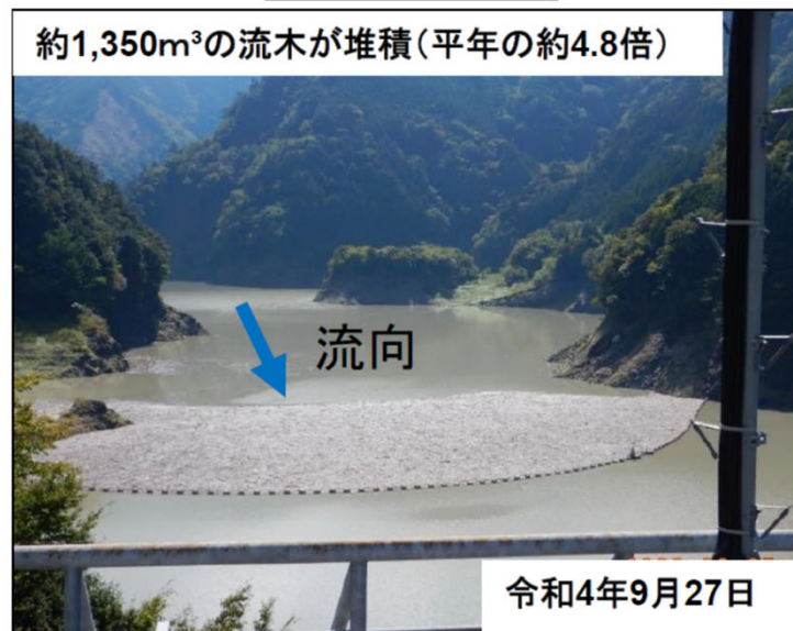
被災後の状況
