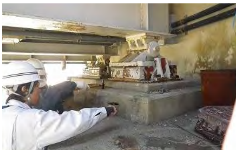
▲ ハンマーによる打音点検
