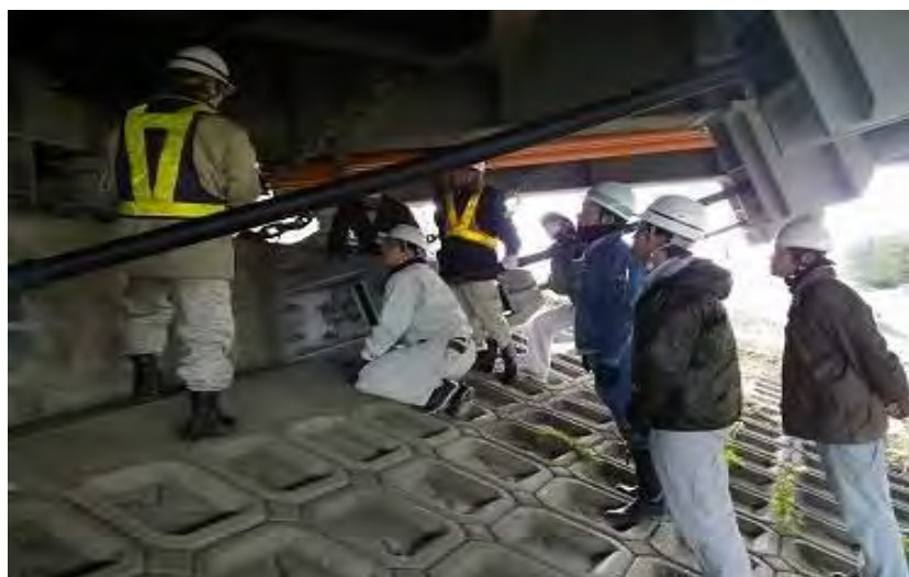
▲ 支点部の点検ポイントの説明
