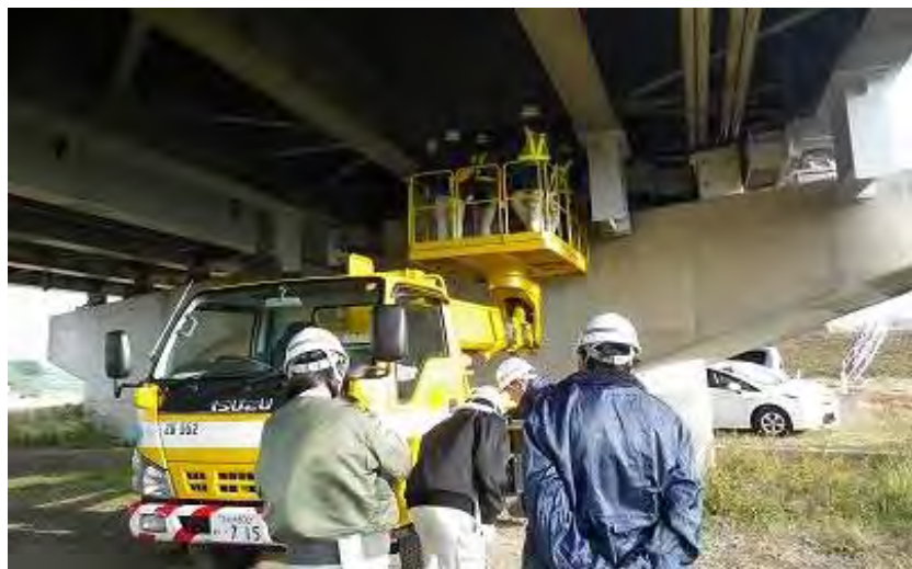
▲ リフト車稼働状況
