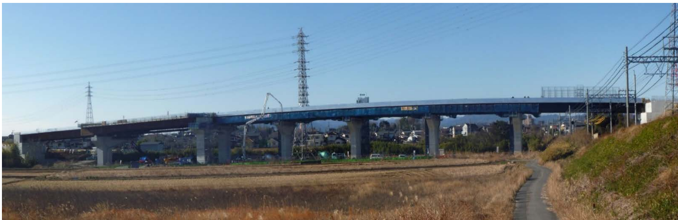
【写真①】つながった相川高架橋(仮称)
